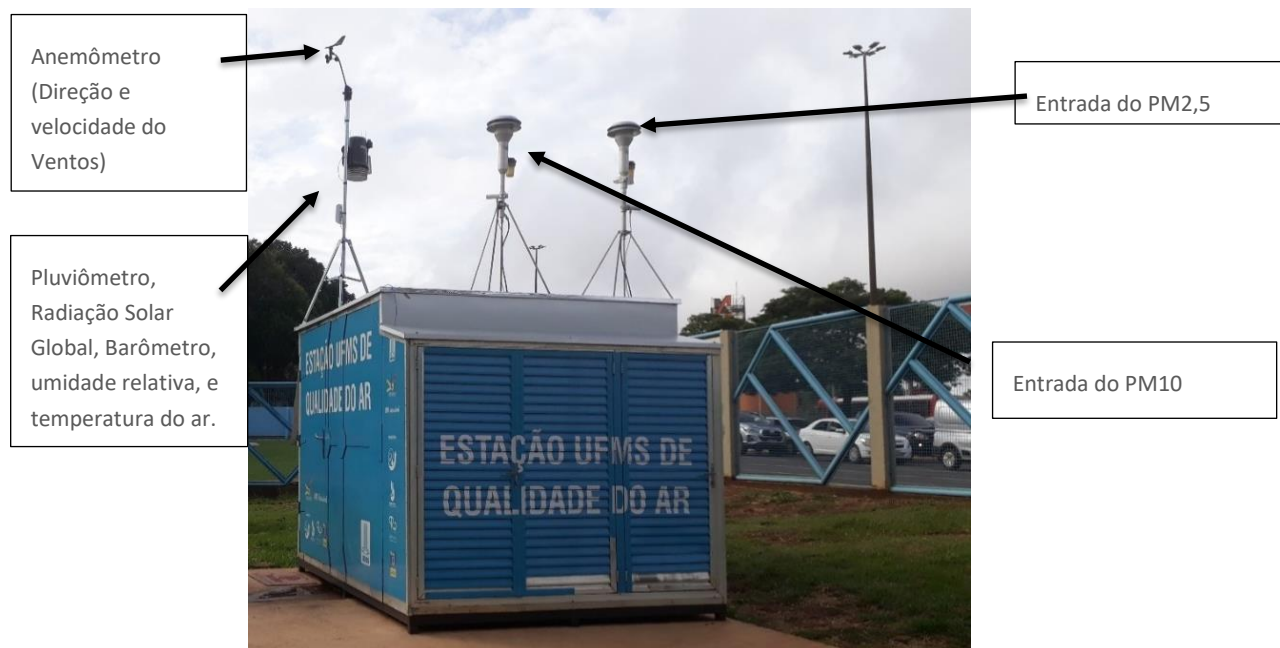
Figura 2. Estação de Monitoramento da Qualidade do Ar
